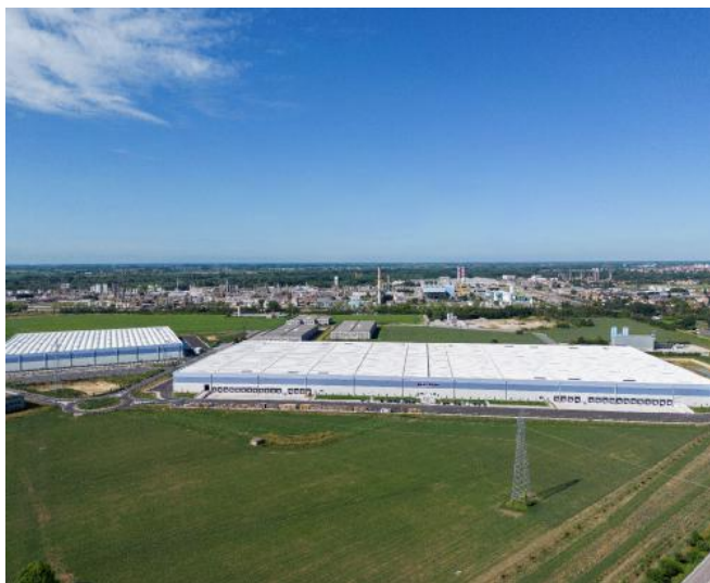
A Valdaro i capannoni dove Gxo gestisce la logistica di Leroy Merlin
